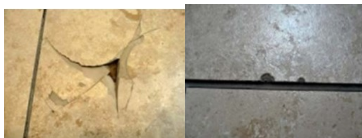
Сурет 2 - Шеттер мен жарықтарға жақын кетіктер
