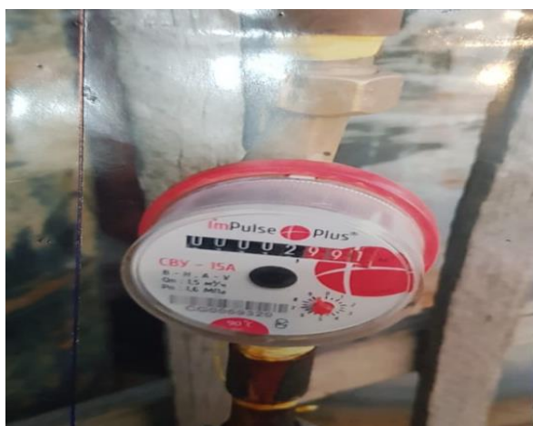
2-Сурет - «ImPulse Plus» қалақты су есептеуіш (MP-3 типідегі. №11032183)
