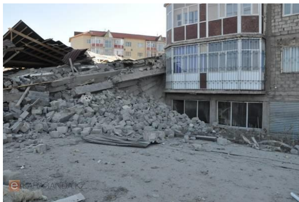
1-сурет – Қарағанды қаласындағы 5 қабатты 124 пәтерлі тұрғын үй ғимаратының құлауы
