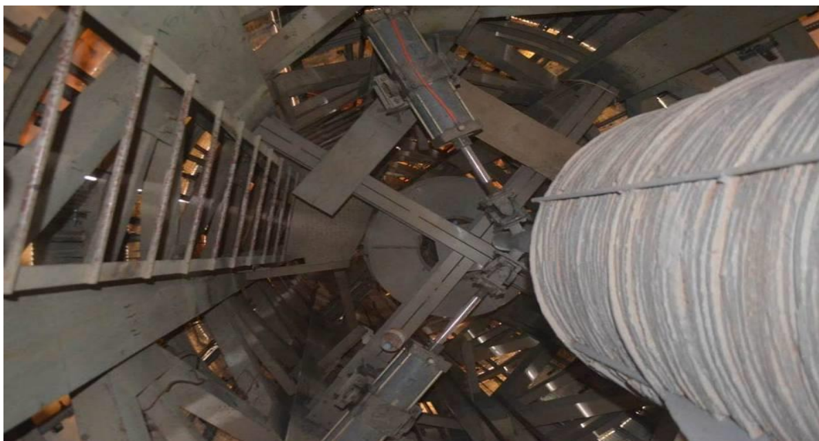
Рисунок 2 – Общий вид установленных конструкций динамического гасителя колебаний (ДГК)
