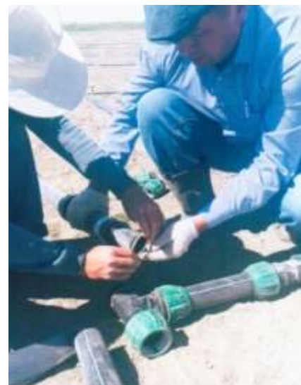
Рисунок 2 - Наладка системы внутрипочвенного орошения
